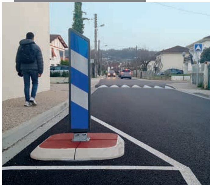
Rue de Ribas réaménagée
